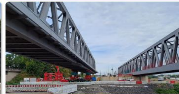
Einfahren des zweiten Überbaus
