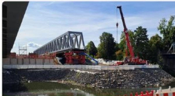
Einfahren des zweiten Überbaus
