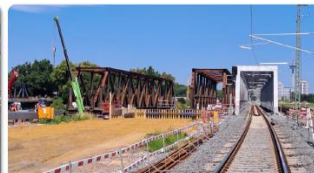
Ausfahren der alten Brücken
