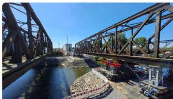
Ausfahren der alten Brücken
